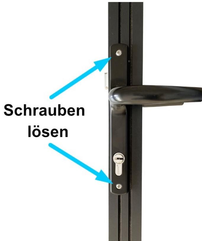
(Abb. Türgriff mit Schrauben am Türprofil, Ansicht von der Rückseite / Innen)
